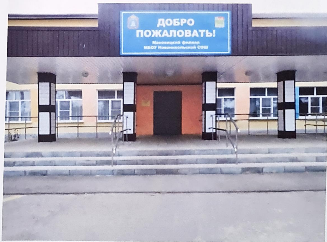
Фото 3. Входная площадка (перед дверью)
