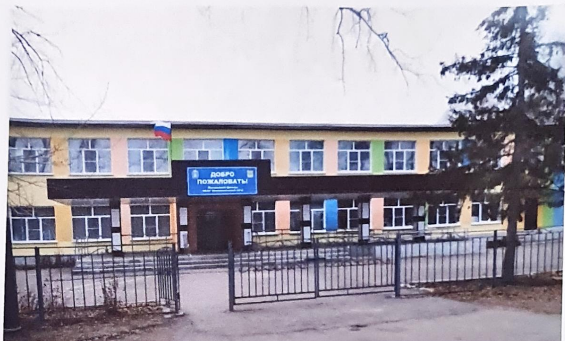
Фото 2. Вход на территорию
