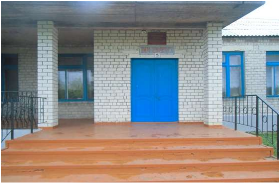
Фото 4. Входная площадка (перед дверью)
