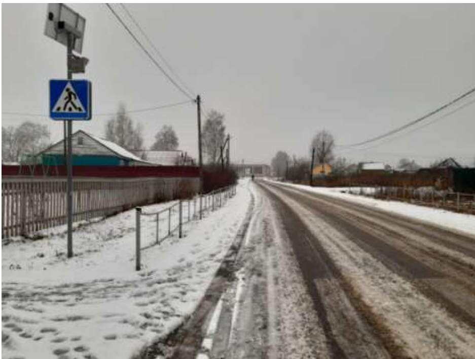
Фото 10. Пути движения к объекту (от остановки транспорта).
